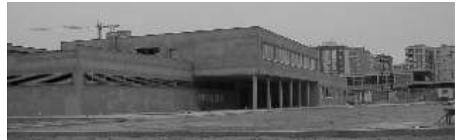
Façana oest (c/Columbretes) amb els vestidors en 1r terme
