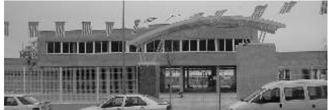
Façana oest (c/Columbretes) amb l'entrada a l'instal.lació
